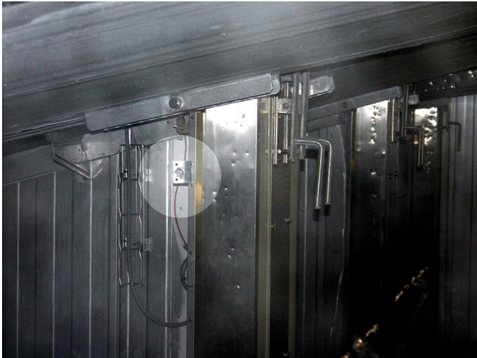
Induktive Näherungsschalter mit Kältetoleranz bis -60\text{ }^{\circ}\text{C} prüfen, ob Abtauklappen in Gefrieranwendungen ordentlich schließen
