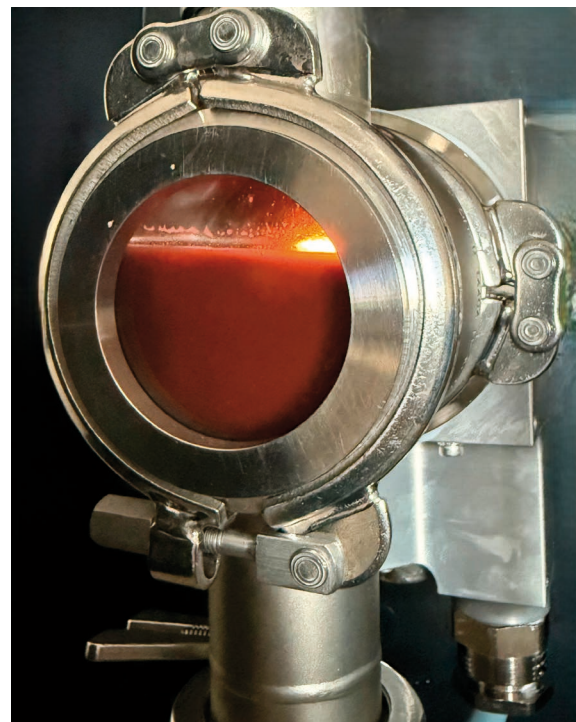
Bild 7: Idealer Ort für die Kontakt-Messköpfe an Rohrleitungen ist z. B. der Abgang von der Conche.
