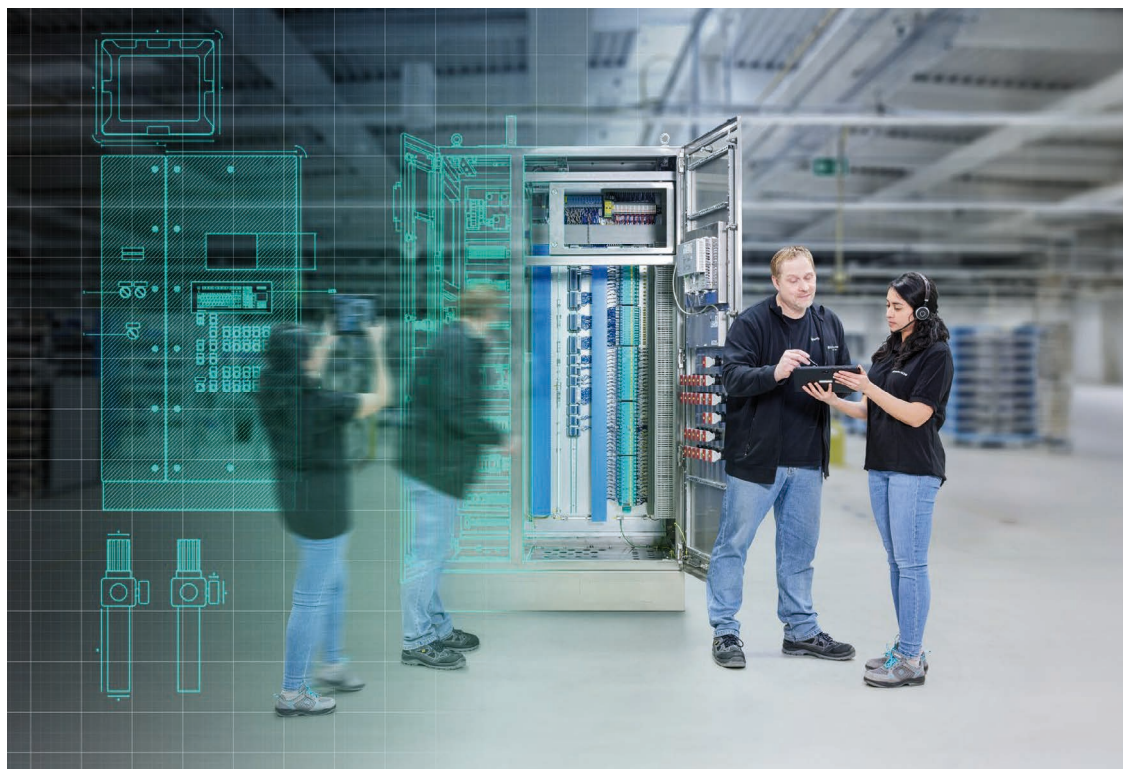
Die Geräte-Dokumentation ist auf Mobilgeräten im Feld verfügbar.
