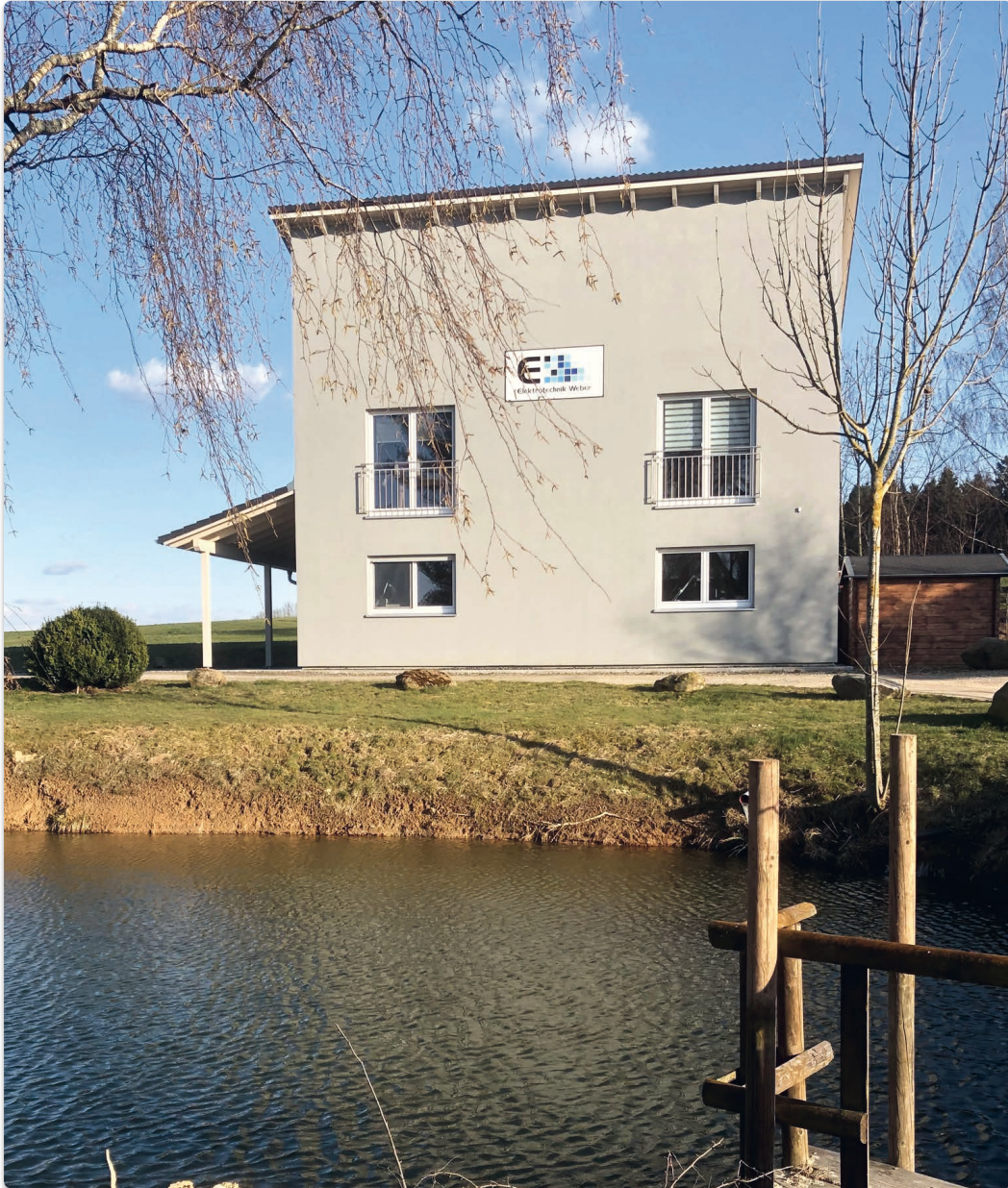
Bild 2: Das Firmengebäude von Elektrotechnik Weber ist ein Effizienzhaus; geheizt wird zu einem großen Teil über die Abwärme der Maschinen. Das extrem weiche Wasser für das Reinigen der Leiterplatten stammt aus der eigenen Quelle. Benötigten Medien werden vor Ort erzeugt
