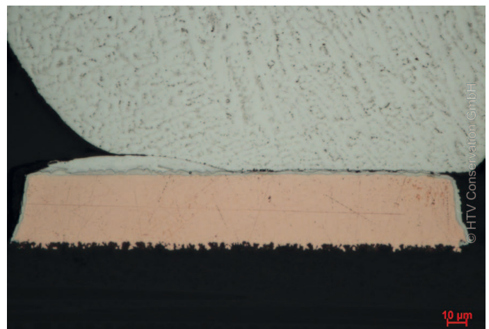
Schliff durch BGA-Lötstelle mit Nicht-Benetzung auf der Leiterplattenseite
