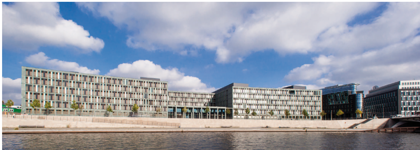
Bundesministerium für Bildung und Forschung, Berlin, installiert nach SMI-Standard (Bild: Wolfgang Reiher, photography)
