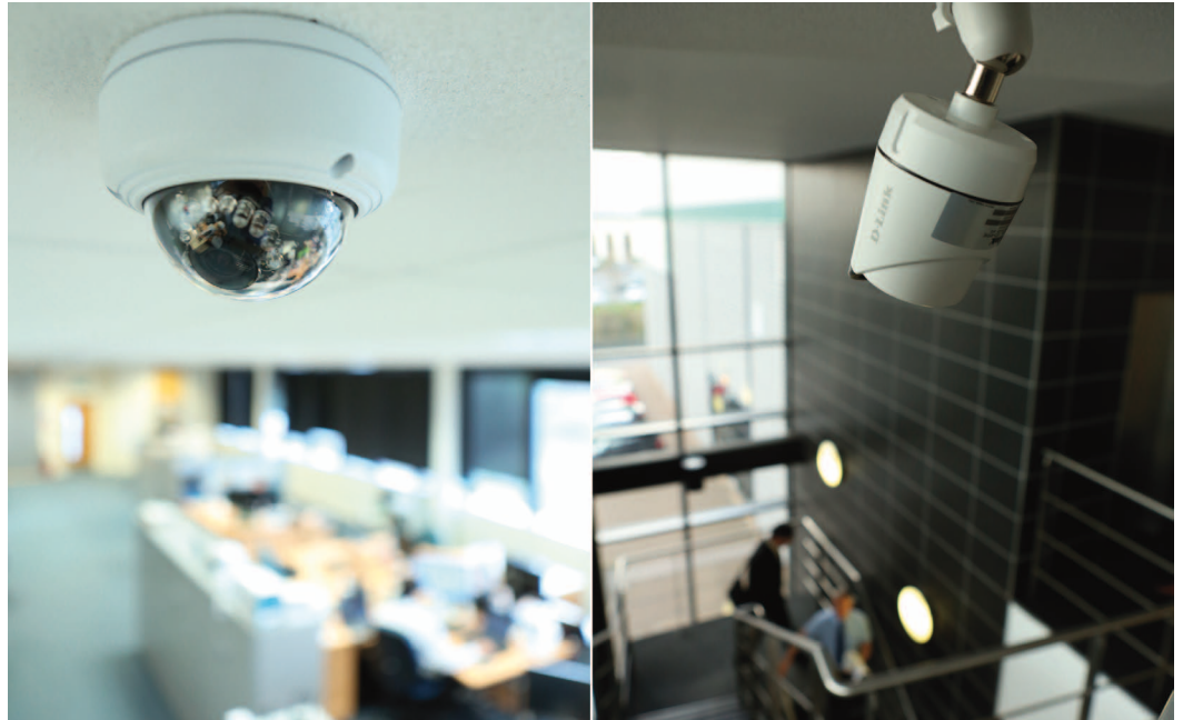
Im deutschsprachigen Raum sind vor allem die Gehäuseformen Kuppelkamera (Dome, links) und Bullet-Kamera (Form einer Patrone, rechts) gefragt © D-Link Europe Ltd.
